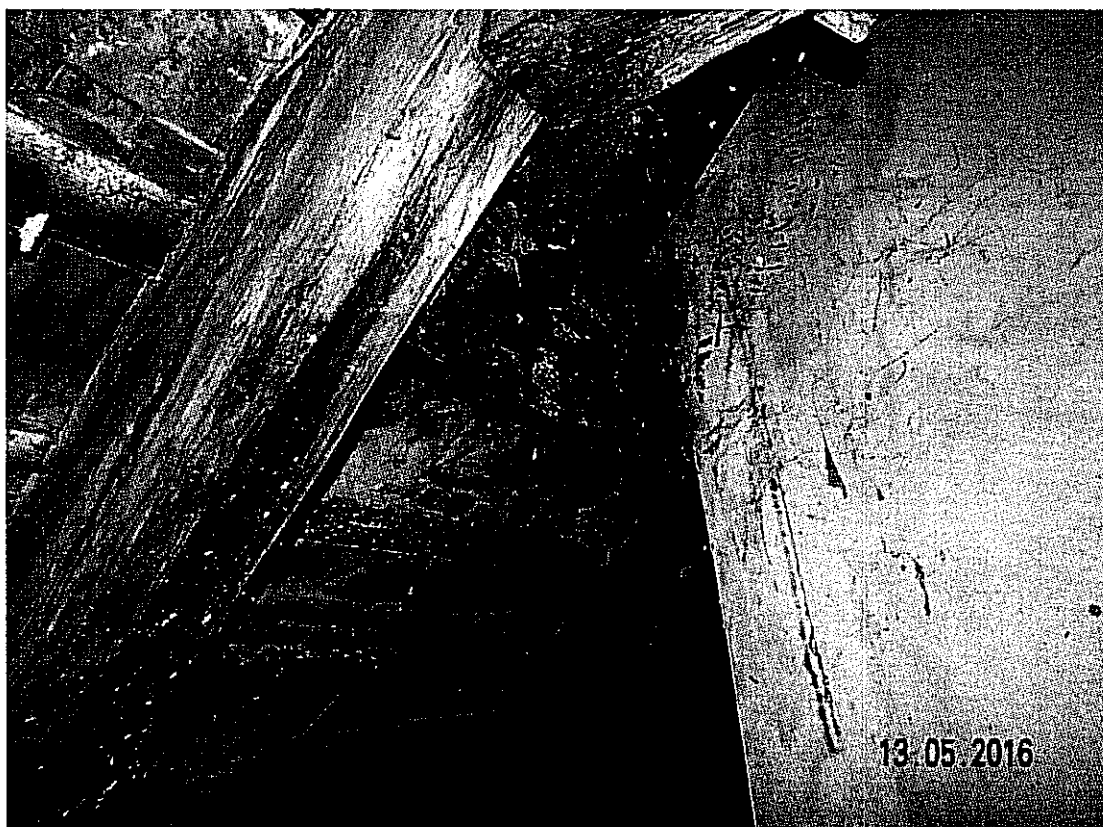
(Poddasze – zniszczony wymian przy kominie)
